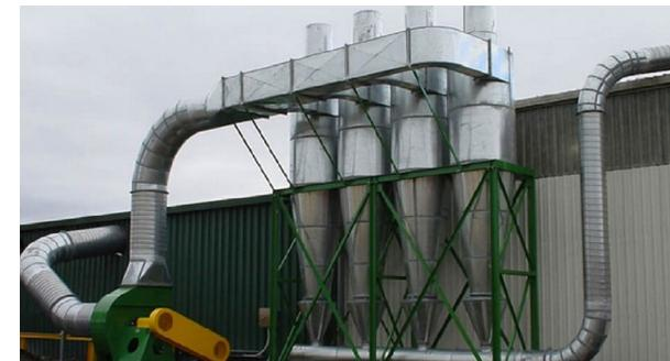
Рисунок 40 — Циклонная система очистки
