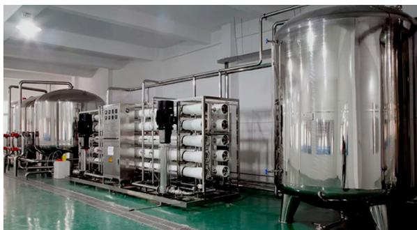
Рисунок 38 — Станция водоподготовки
