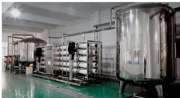
Рисунок 35 — Установка для очистки воды в медицинской промышленности
